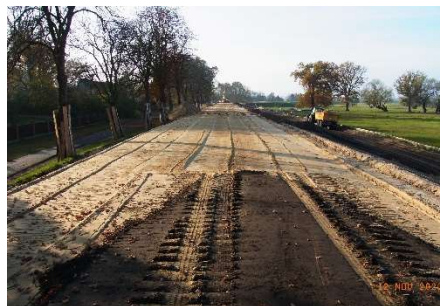
Bild 2: neue Deichkubatur vor Aufbau der Befestigung für die Kreisstraße
