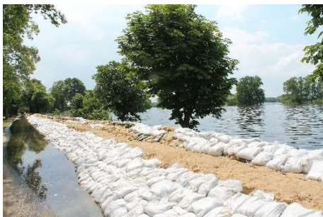
Bild 1: Hochwasserverteidigung im Baulos 3b (K7031), 11.06.2013
