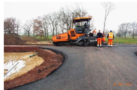
Bild 3: Asphaltierung der Kreisstraße K7031 auf der Deichkrone
