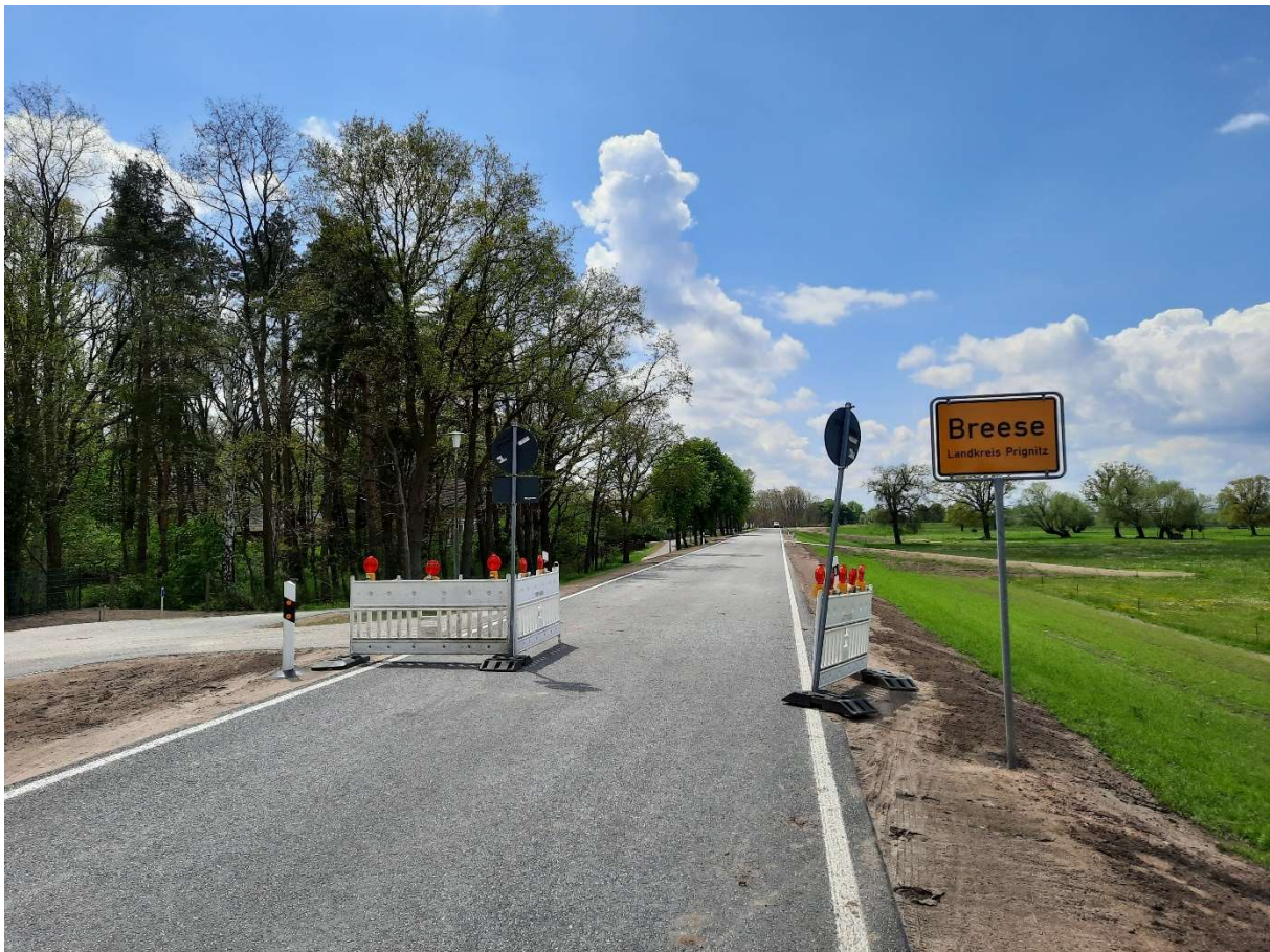
Bild 4: fertig gestellte Kreisstraße K7031 auf der Deichkrone
